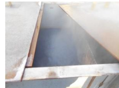
H-36号井に設置されている熱水堰と流れる熱水の様子
