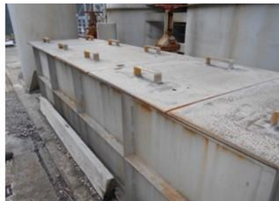
H-36号井に設置されている熱水堰と流れる熱水の様子
