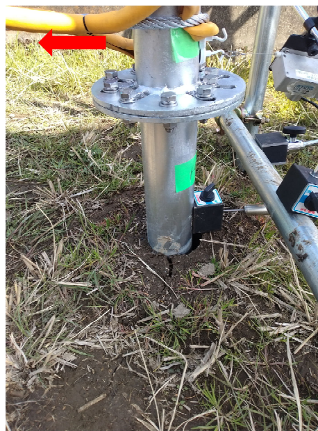
杭の水平載荷試験 (載荷点：高さ300mm)
