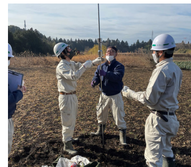
農地での地盤調査
