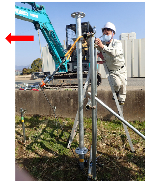
杭の水平載荷試験 (載荷点：高さ2000mm)
