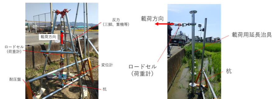
農地での杭基礎載荷試験
