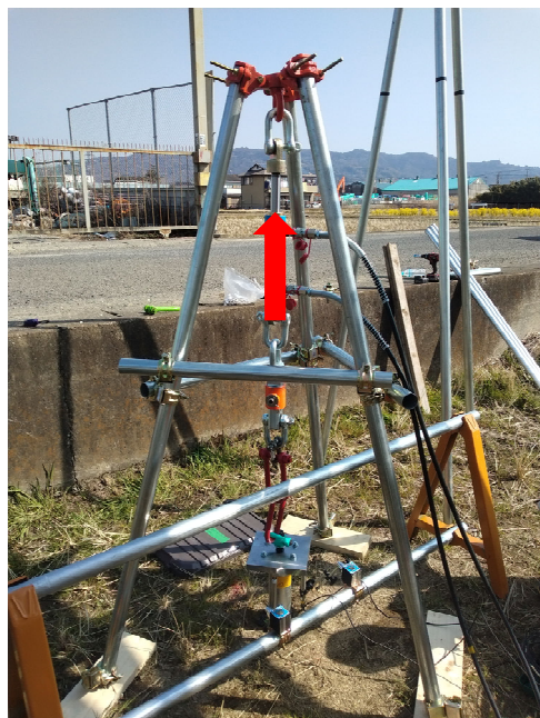
杭の引抜き載荷試験
