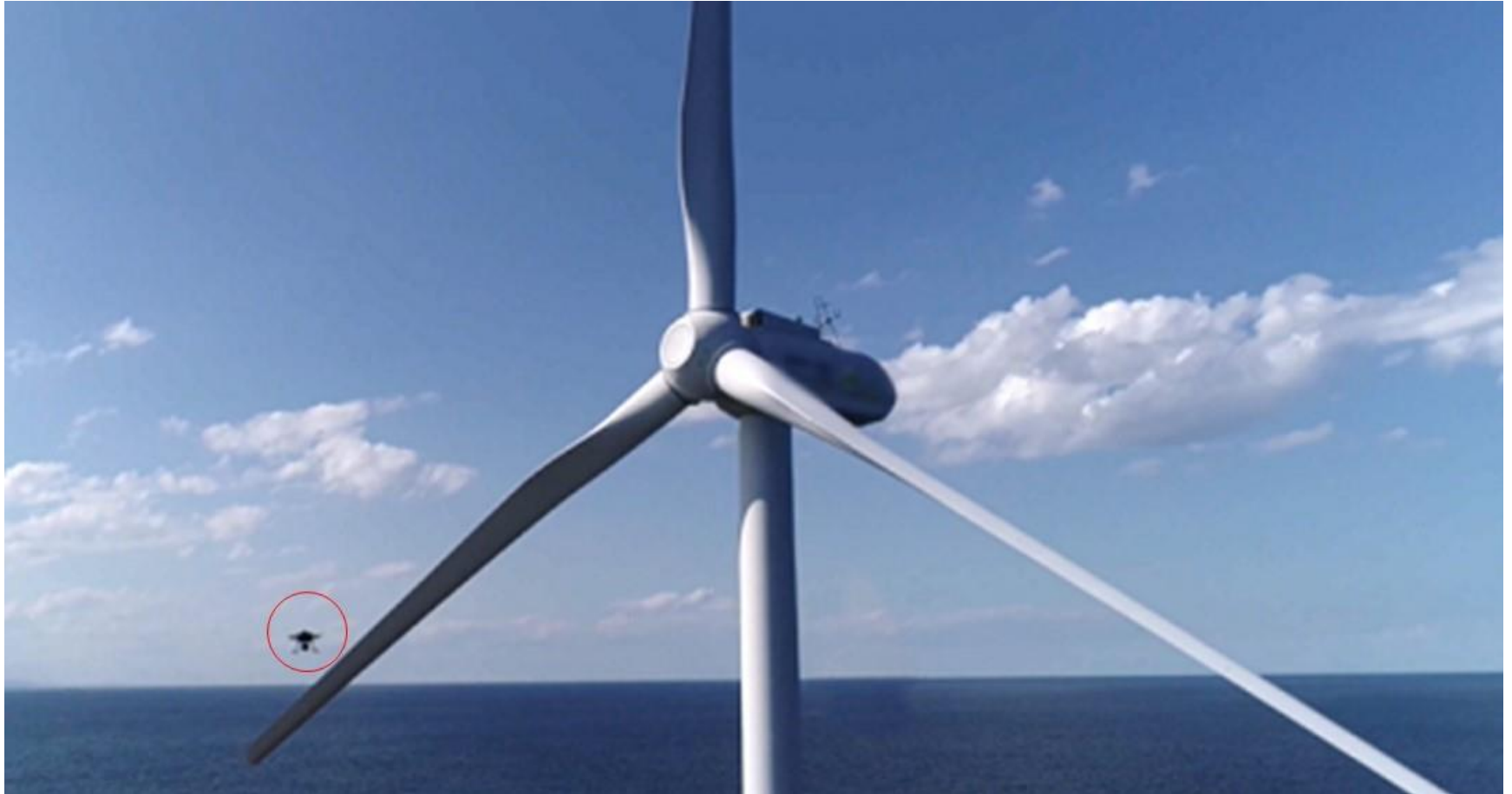
実証試験状況 (別UAVで撮影)
