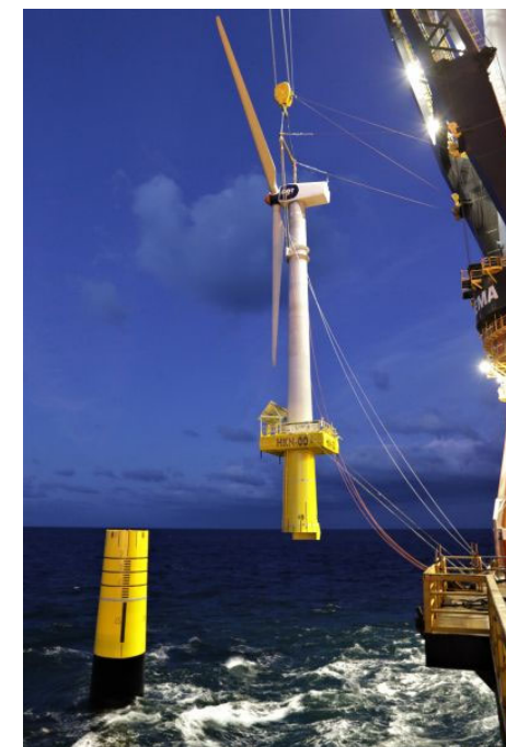
SJOR スリップジョイント設置
