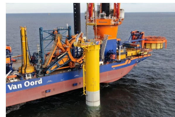
Borssele V スリップジョイント設置
