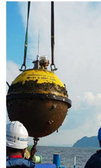
波浪ブイ撤去作業
