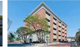
北部総合教育研究棟 (地下1Fに培養装置群を設置)
