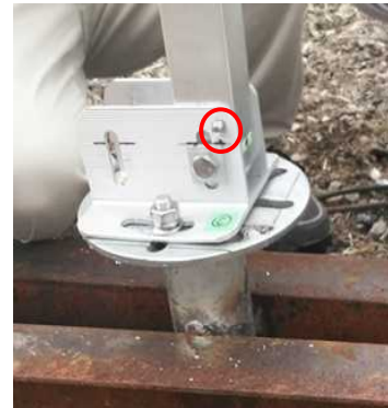
図Ⅲ-2-(ロ)-(i)-D-12 ドリルネジ補強
