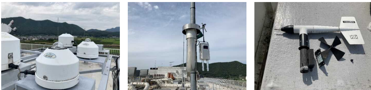
図Ⅲ-2-(ハ)-(ii)-A-1 岐阜地点の精密点検作業
