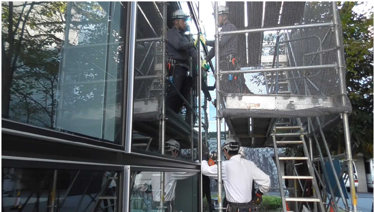
図Ⅲ-2-(イ)-(ii)-H-5 (開口部太陽電池交換工事風景) (通常の建材窓ガラスと同じ工法)
