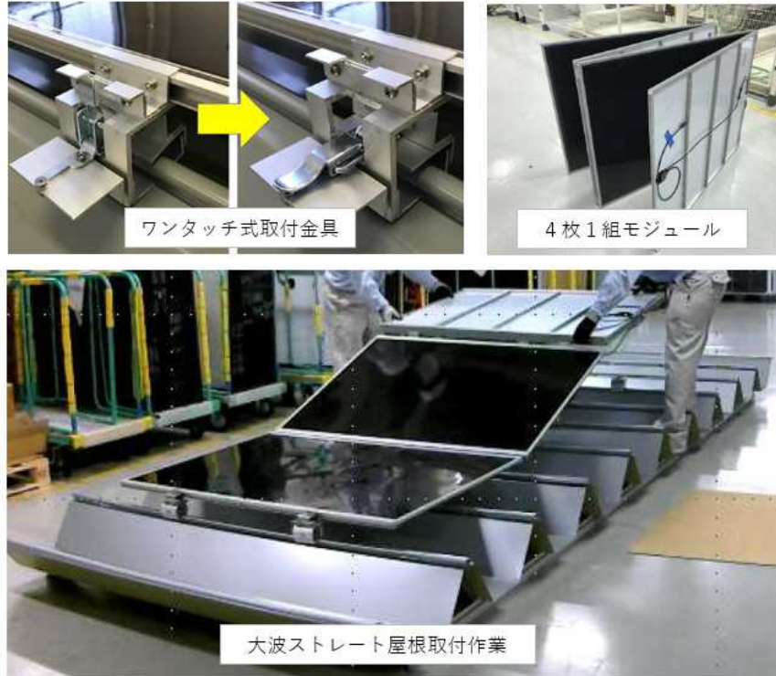
図Ⅲ-2-(イ) -(i)-D-7 折り畳み式軽量モジュールとワンタッチ金具を用いた作業
