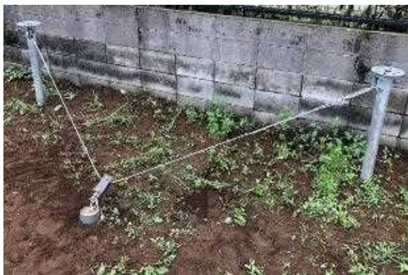
図Ⅲ-2-(ロ)-(i)-D-1 杭補強の施工事例
