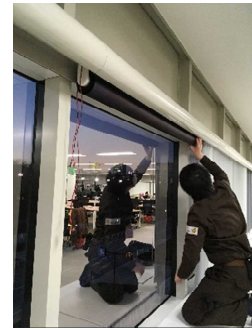
図Ⅲ-2-(イ)-(ii)-M-4 BIPV ロールスクリーンの取付施工時
