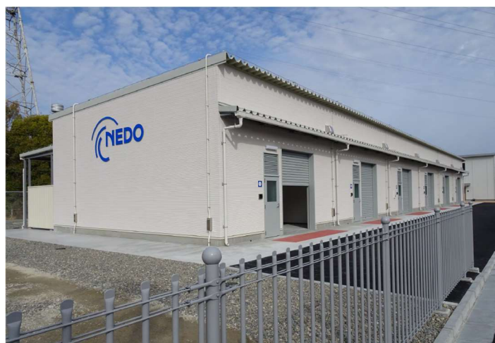
図 3.2.1.2-11 研究棟の竣工状況(正面側)(2022年3月29日)
