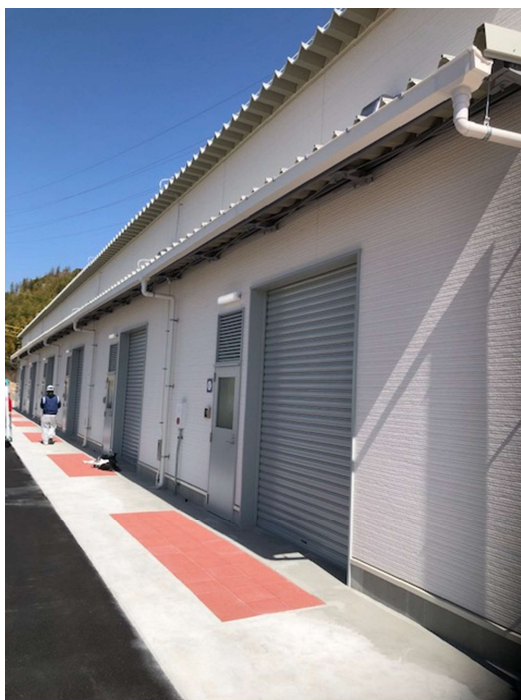
図 3.2.1.2-15 研究棟前面の外溝部(犬走)の竣工状況(2022年3月23日)
