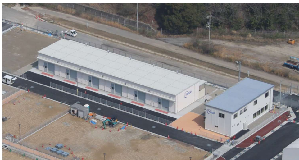
図 3.2.1.2-7 基礎先導拠点の竣工状況(2022年3月29日)
