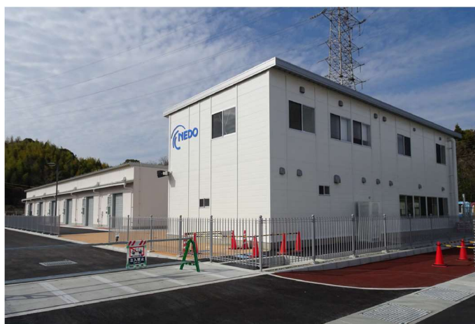
図 3.2.1.2-9 共用棟の竣工状況(2022年3月29日)
