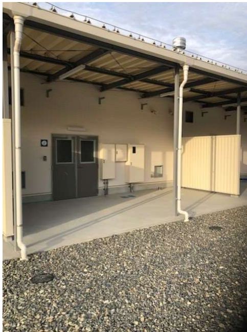
図 3.2.1.2-13 研究棟の竣工状況(背面側拡大)(2022年3月23日)
