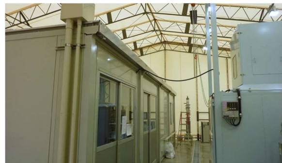
図 3.2.2.3-10 テント内プレハブ研究室
