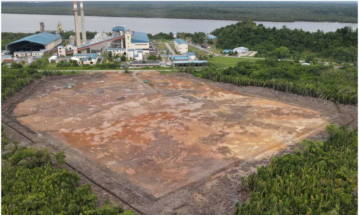
図 1 2021 年 8 月における大規模微細藻類培養システム建設の様子。土地の造成が進んでいることが確認される。
