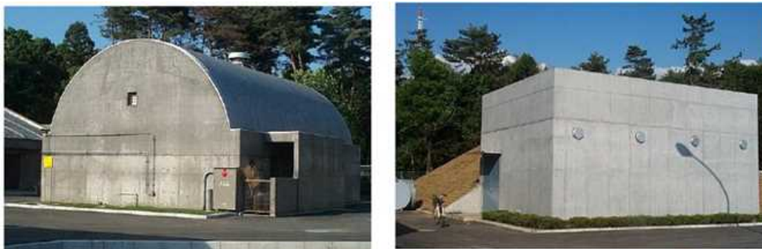
図Ⅲ.2.1.2.3-3 産業技術総合研究所 安全科学研究部門 爆発利用・産業保安研究グループが保有する爆発安全性試験用の設備の外観
