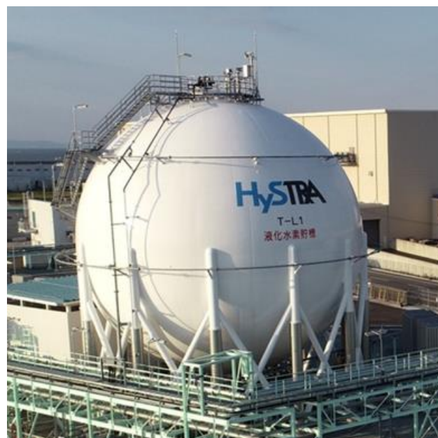
図 33 貯蔵タンク全景（設置完了後）
