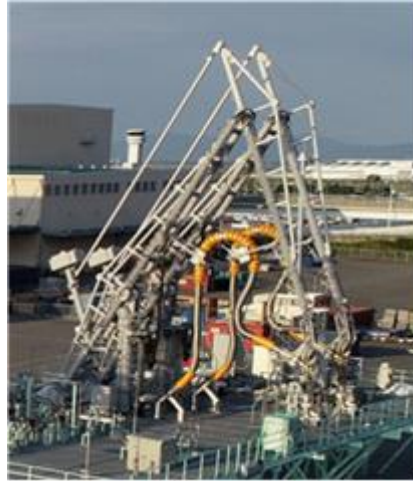
図 27 ローディングアーム全景（据付完了後）
