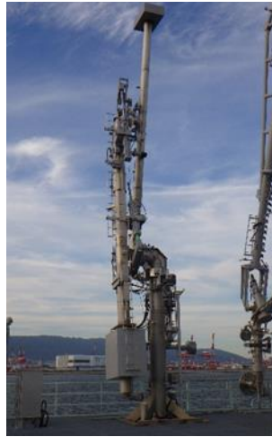
図 39 鋼管型ローディングアーム（据付完了時）
