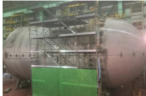
図 12 外槽製作状況
