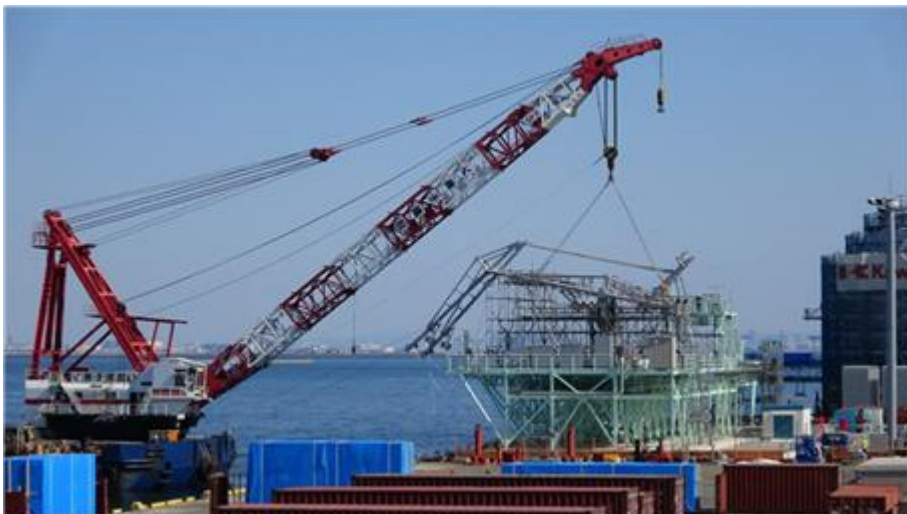
図 26 ローディングアーム現地据付の様子（2020 年 2 月）
