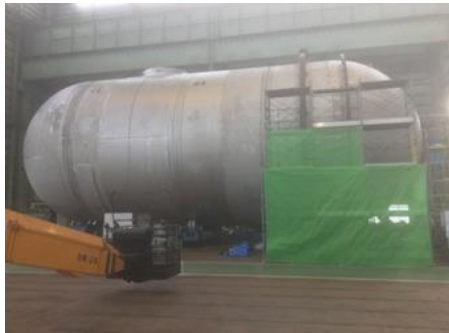
図 11 内槽製作状況
