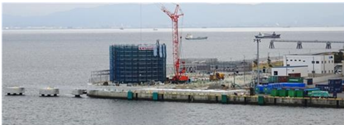
図 30 荷役基地建設状況（2019年3月現在）
