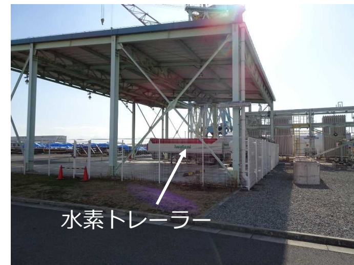
水素トレーラー駐機場
