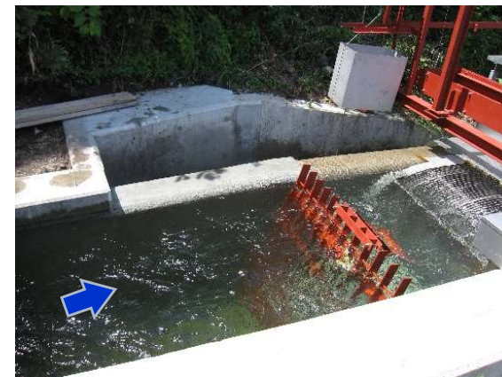
実証運転状況
