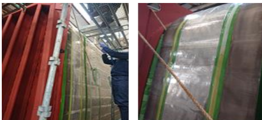
図 3-2.5.7-45 構体結合部に施工したシャワー式化成処理の外観
