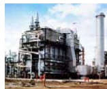
加熱炉 高温の断熱材
