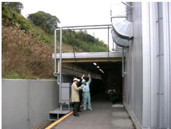
写真 A-(1)-6 排気ダクトから分取
