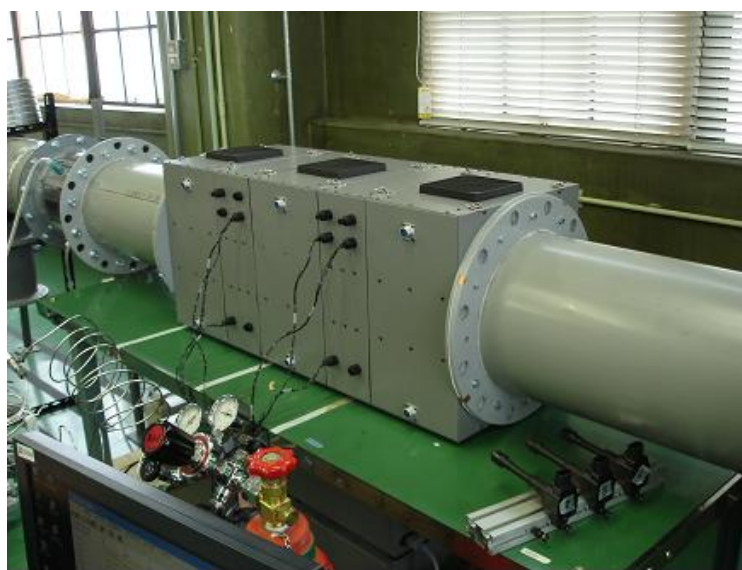
図 A-(5)-11 ホルムアルデヒド分解装置の排気ダクトへの設置風景
