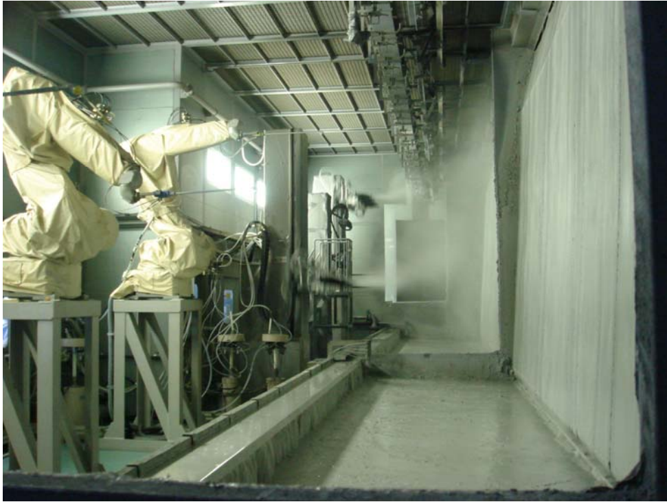
図 B-(2)-11 塗装ブース 手前は内板塗装用ロボット、奥に外板塗装用レシプロケーター
