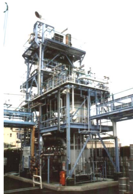
液中燃焼炉 (ダイキン工業(株)淀川製作所)
