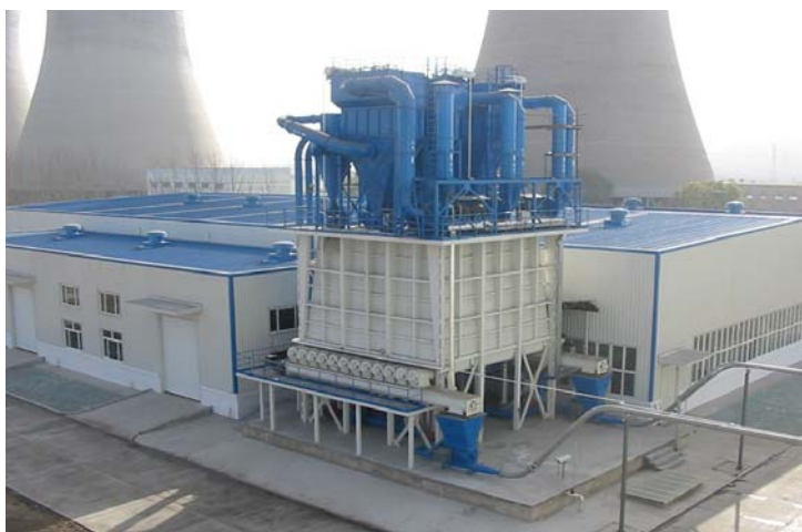
華電集団の傘下にある山東省二十里泉バイオマス混焼発電プラント(設備容量 140MW)
