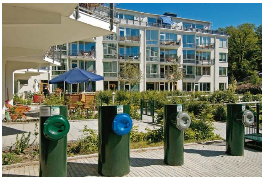
Envac 社のゴミ回収システム（Underground Waste Management System）
