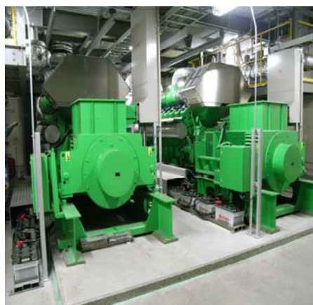
写真 3 : 埋立地ガスによって作動する発電機を動かすレシプロエンジン(米国 GE 社のイエンバッハ・ガスエンジン「タイプ 6」) – GE 社提供)
