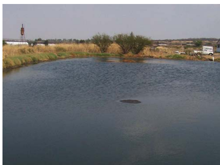
写真1：湖水が嫌気性発酵装置を経た潟湖(メキシコミチョアカン州ラピエダッド市内サンタモニカ農場の潟湖)：潟湖は密閉式家畜舎での畜産の際、厩肥の安定化処理 注11 及び一時的貯蔵に用いられる。
