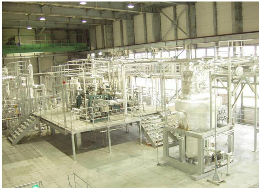
佐賀大学海洋エネルギー研究センターには、30kW 海洋温度差発電装置が設置されている。最近の研究成果では、濃度 99%以上のアンモニア/水作動流体を用いた場合に、温度差 21℃、温水流量 111kg/s、冷水流量 111kg/s で最大正味出力約 20kW を得ている。また、温・冷海水を模擬した海水淡水化実験装置でも効率よく淡水化できることを実証している。
