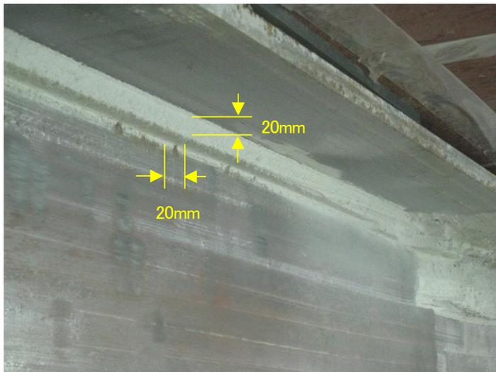
図 5.3-6 入隅部の剥離残り状況
