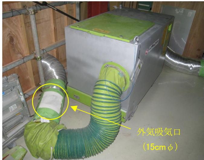
図 5.3-12 集塵機ダクト部の外気吸気口
