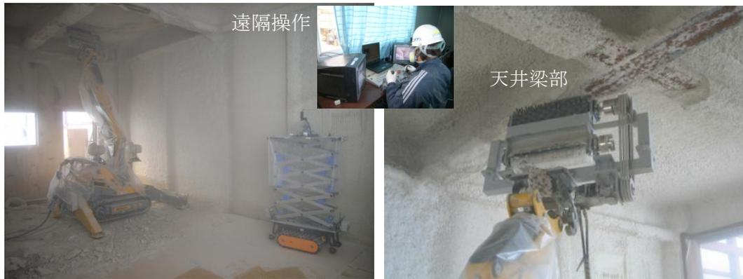
写真 6-12 遠隔操作による除去実験状況
