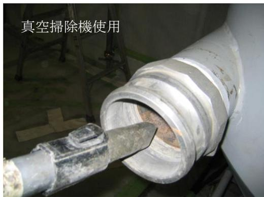
写真 7-16 回収・袋詰装置 (清掃中)
