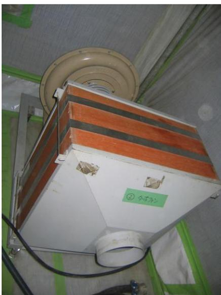
写真 7-18 排気浄化装置 (清掃後)
