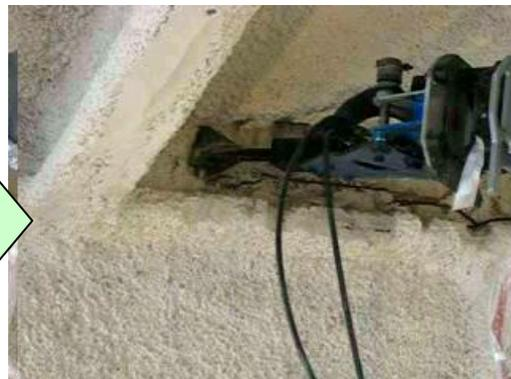
写真 6-5 打撃式大型チッパー
