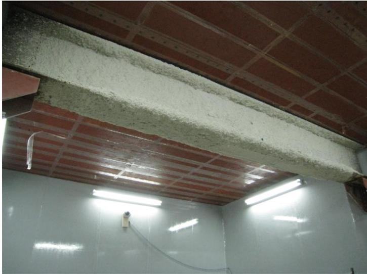
図 5.2-4 実大鉄骨梁モックアップ
