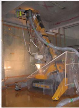
高圧水噴射ノズル (乾式系除去)
