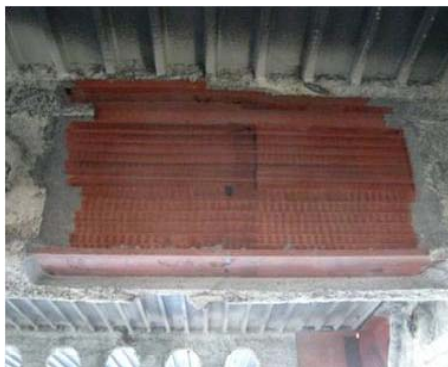
剥離後の状況
