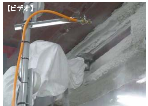
梁部 (t40~50mm) 剥離実験
