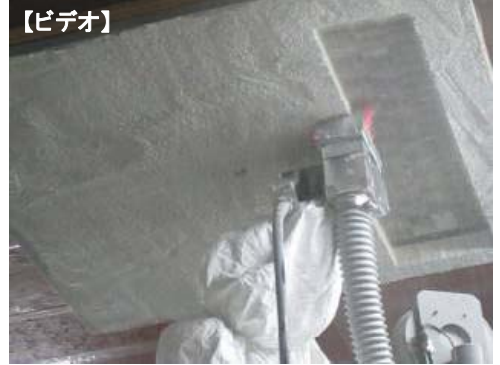
天井部 (t20~25mm) 剥離実験
