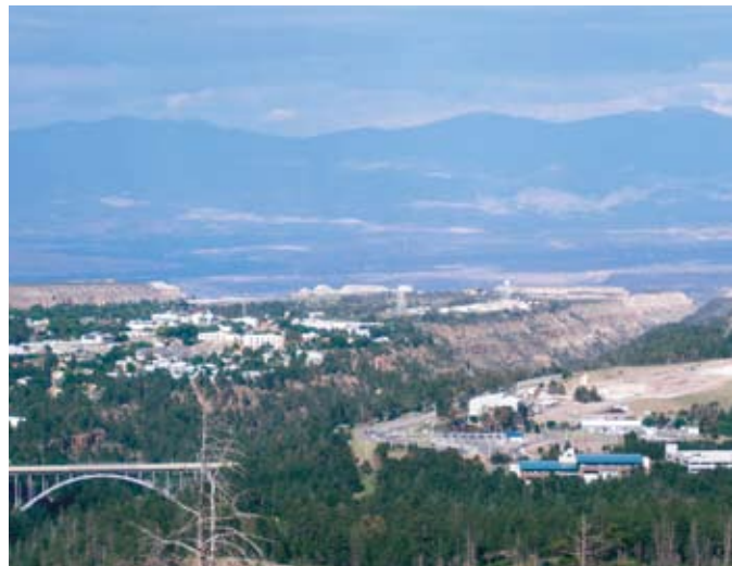
米国・ロスアラモス郡のスマートグリッド実証サイト
