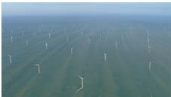
Thanet 洋上ウィンド・ファーム ロンドンの西、テムズ川河口にある大規模洋上ウィンド・ファーム(300MW)の建設
