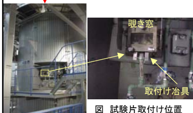
図 試験片取付け位置
