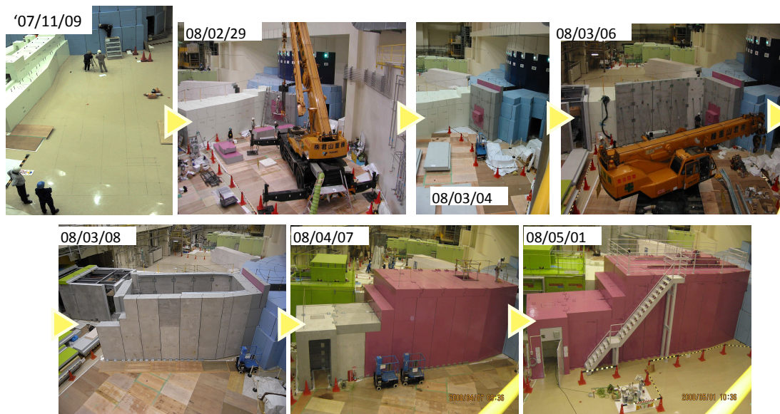
図III.2.5.-(39) NOVA 中性子遮蔽材設置作業の様子。
