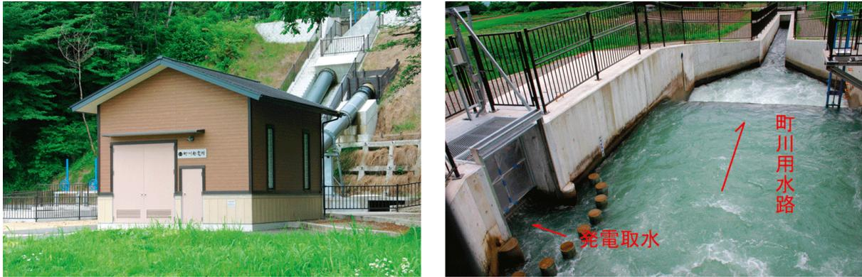
図 8-1 用水路発電設備の一例（町川発電所，最大出力 140kW）
