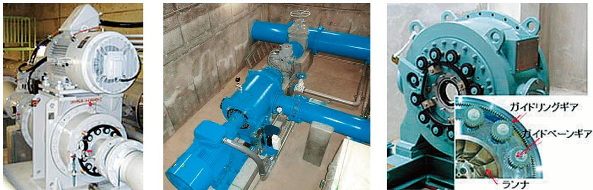
図 8-22 田中水力のリンクレスフランシス水車の設置例
