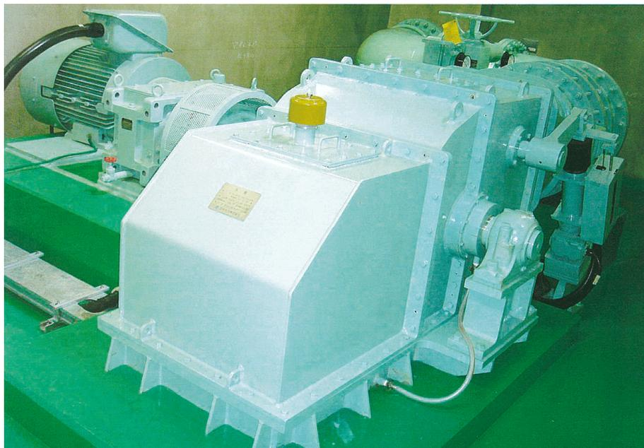
図 8-17 火力発電所の冷却水系統に設置した小水力発電設備例（沖縄電力宮古第2発電所）
