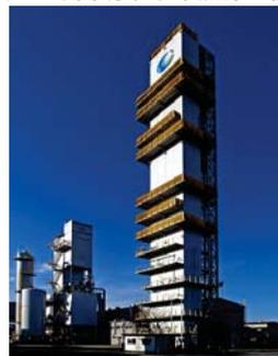
石油ガス・希ガスの極低温蒸留分離装置
