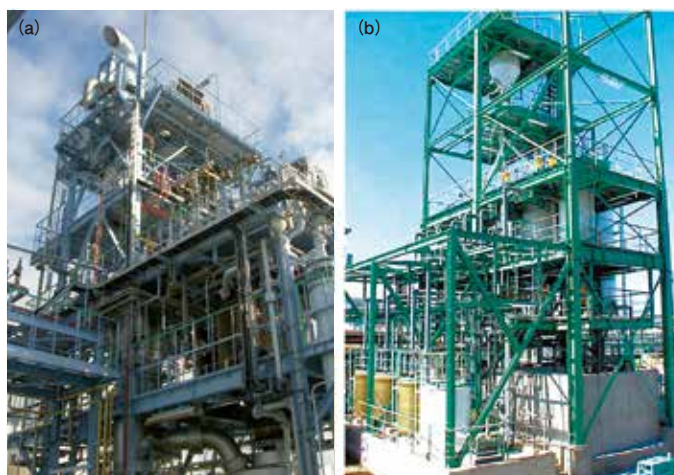
図1 液中燃焼法によるフロン等処理設備 (a)液中燃焼炉(ダイキン工業株式会社淀川製作所) (b)後処理設備(旭硝子株式会社 鹿島工場)
