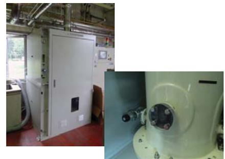
安全な試験のためのHF除害装置
