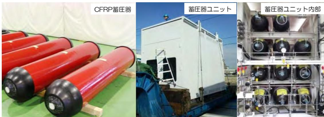
図6. 使用した CFRP 容器の外観及び設置状態
