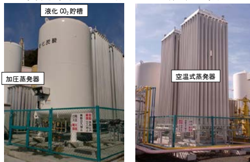
(2) 追設した CO 2 供給設備(CE)
