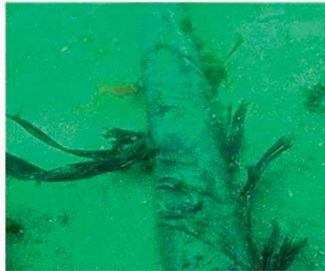
上左図:海底ケーブルの変位状況
