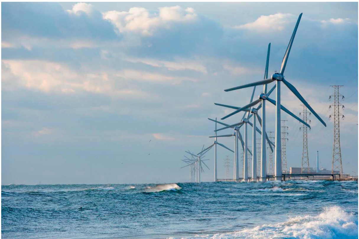
図 3.7.2-70 ウィンド・パワーかみす第2洋上風力発電所の完成時の状況 (小松崎都市開発資料)
