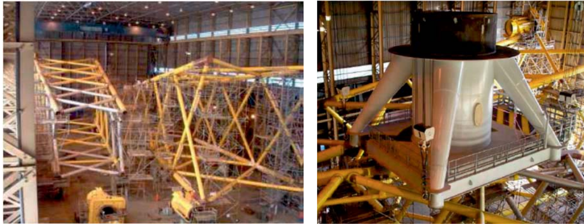
図 3.7.2-40 ジャケット(左図)とトランジションピース(右図)の製作状況(Robertson, 2008)
