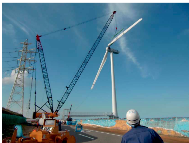
上左図：モノパイルへのボルトタワーの接続 上右図：ナセルへのハブの据付け 下中央図：ブレードの据付け
