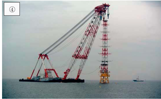
上段：観測塔(1)+支持構造物 ①海上輸送 ②位置合せ・据付け 下段：観測塔(2) ③海上輸送 ④位置合せ・据付け
