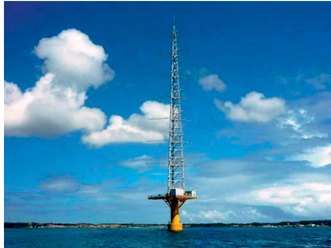
図 3.7.2-57 洋上風況観測タワーの完成時の状況(東京電力・鹿島建設資料)
