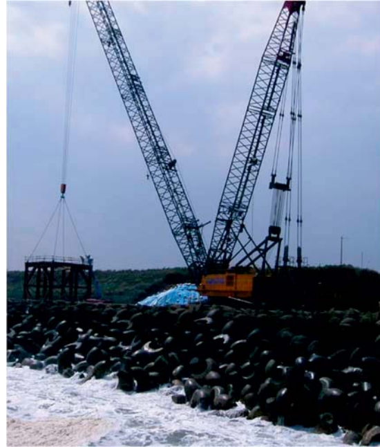
図 3.7.2-10 陸上から作業中のクローラクレーン (岡野, 2010)
