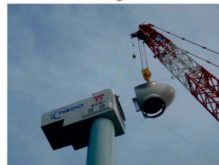
【ローターヘッド据付】
