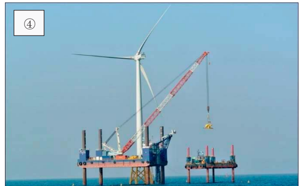
①ブレード No.1 据付 ②ブレード No.2 据付 ③ブレード No.3 据付 ④ブレード据付完了 図 3. 7. 2-66b ブレードの据付け状況 (電源開発資料)
