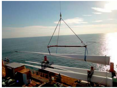
【ブレード吊り上げ】
