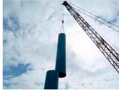
【3節タワー据付】
