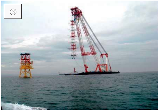
上段：観測塔(1)+支持構造物 ①海上輸送 ②位置合せ・据付け 下段：観測塔(2) ③海上輸送 ④位置合せ・据付け
