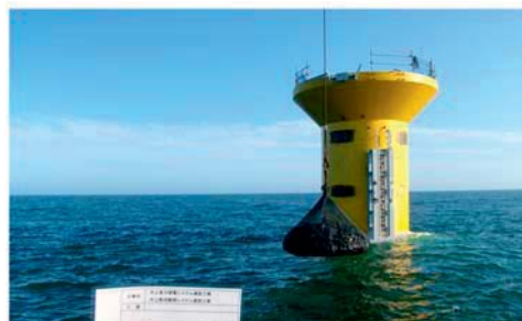
【フィルターユニット設置状況】
