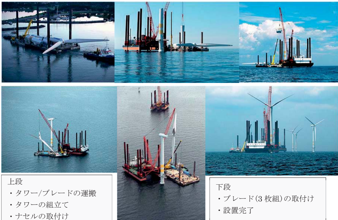
図 3. 7. 2-46 Horns Rev における風車の設置工事
