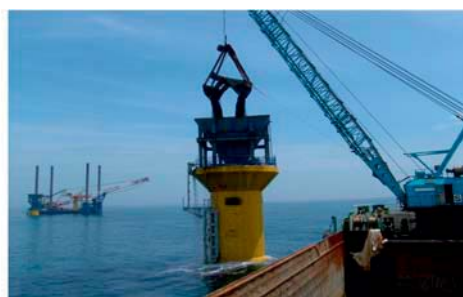
【中詰材投入状況】
