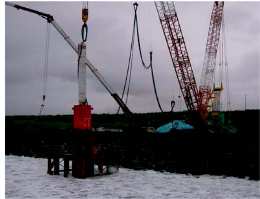
図 3.7.2-12 モノパイル打設状況(岡野, 2010)
