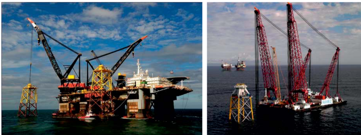
図 3.7.2-42 ジャケットの吊り上げ(左図 : Ballast Nedum, 2011)と据付け(右図 : Robertson, 2008) 状況
