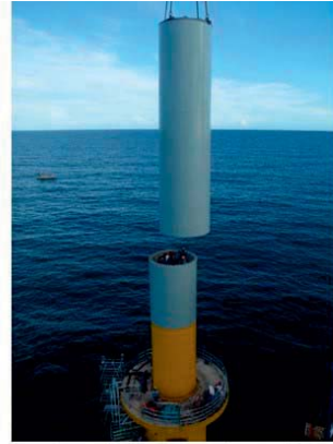
【2節タワー据付】
