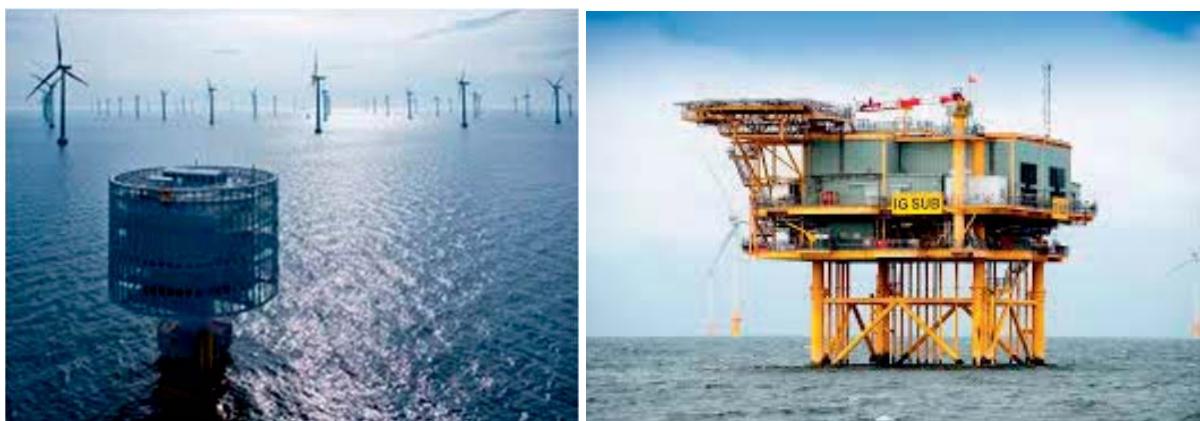
図 3.7.2-81 洋上変電設備の例
