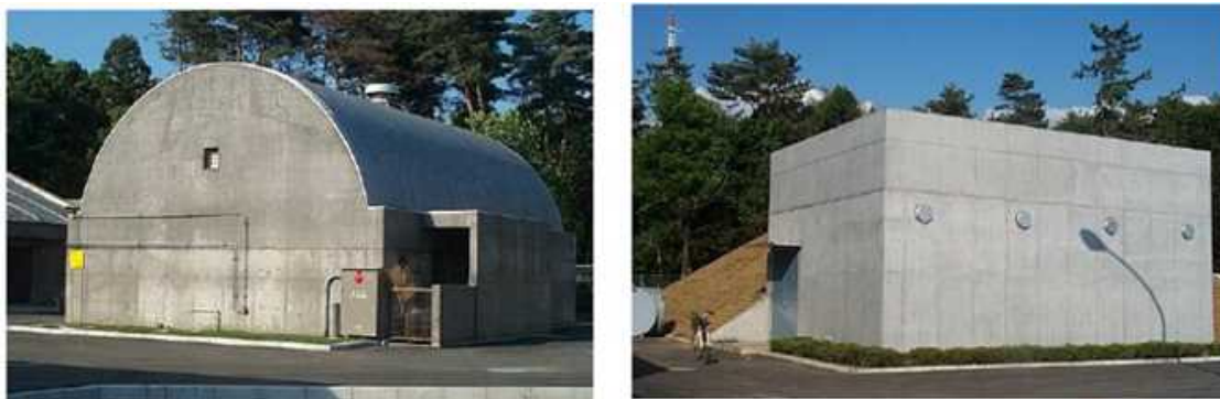
図Ⅲ.2.1.2-18 産業技術総合研究所 安全科学研究部門 爆発利用・産業保安研究グループが保有する爆発安全性試験用の設備の外観
