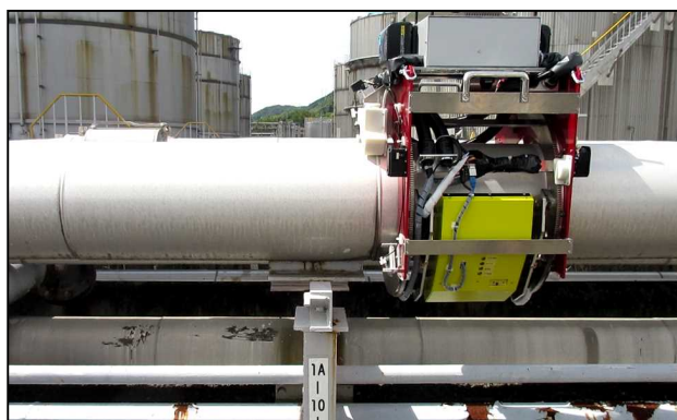
図III-【③-(2)】-5 フィールド試験中の中性子水分センサ搭載ロボット
