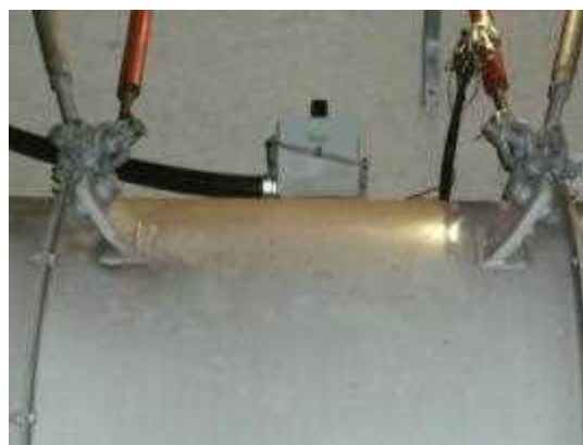
(a)端子箱上蓋交換(センサ端末設置)の様子 (b)端子箱上蓋交換後(センサ端末設置)
