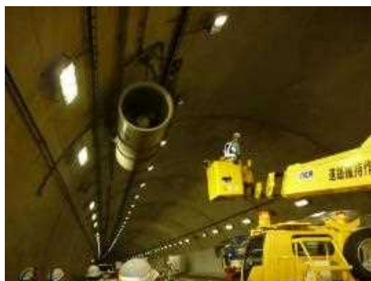
(a)端子箱上蓋交換(センサ端末設置)の様子 (b)端子箱上蓋交換後(センサ端末設置)
