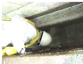
図Ⅲ-【③-(1)-4】- 3 狭隘空間の近接目視
