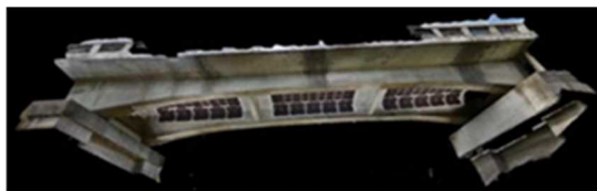
図Ⅲ-【③-(1)-1】-4 高精細画像取得用マルチコプタが取得した画像
