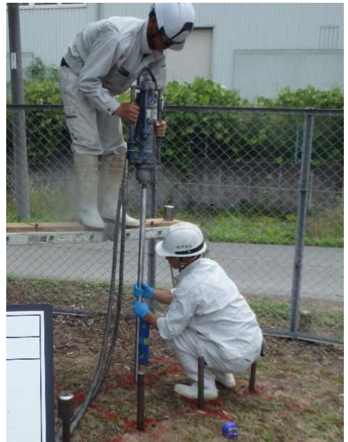
図Ⅲ-2-①-(6)-19 杭打設風景
