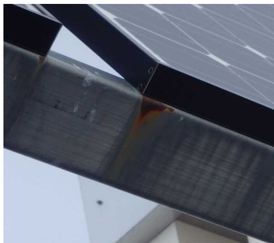
図Ⅲ-2-①-(6)-10 水みち腐食発生事例
