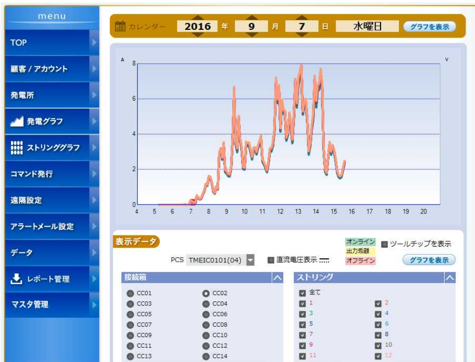
図Ⅲ-2-②-(1)-15 発電モニタ「ストリング監視画面」
