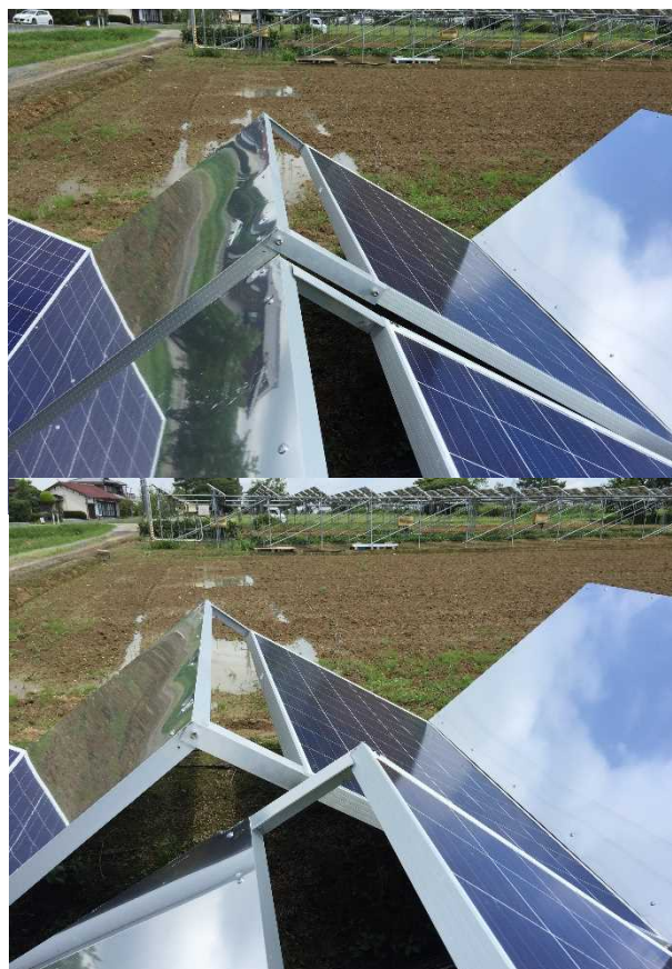
図Ⅲ-2-①-(4)-5 角度可変の反射板を取付けた架台
