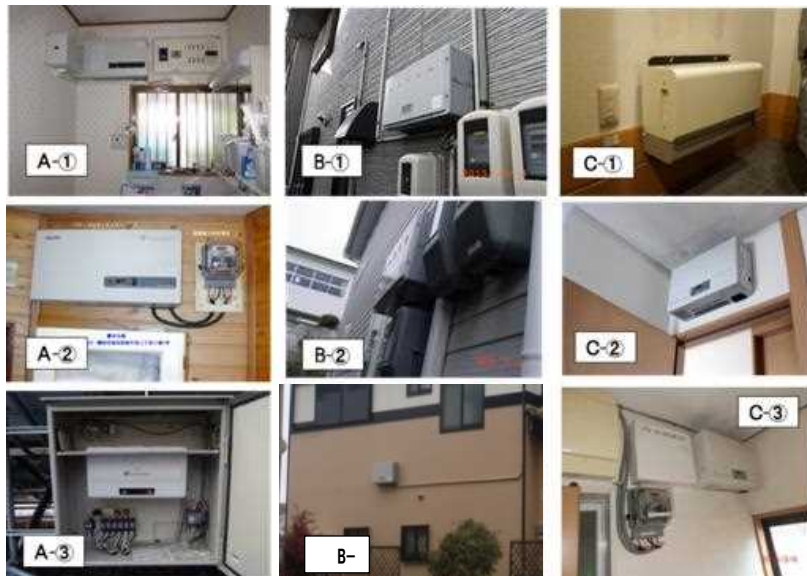
図Ⅲ-2-①-(1)-8 回収前の PCS の設置状況
