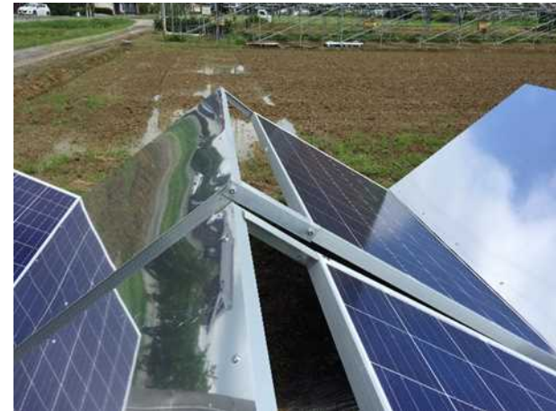
反射材を取り付けた架台
