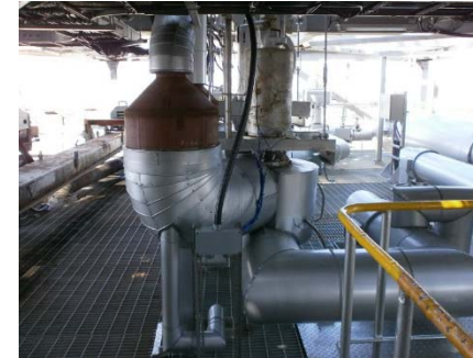
実缶試験 弁据付 熱電対取付け
