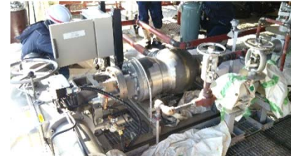
実缶試験 弁据付 各センサー取付
