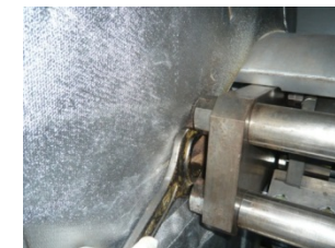
グランドパッキンシール状況確認
