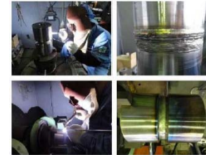
溶接施工法の検証
