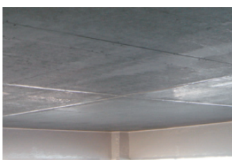
栈橋下面埋設型枠としての利用
