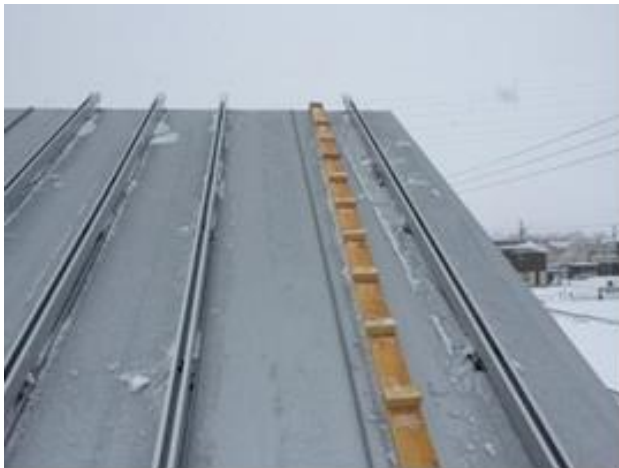
集熱パネル施工写真①
