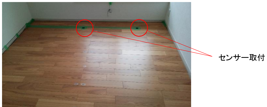
潜熱蓄熱材（PCM床材）施工写真
