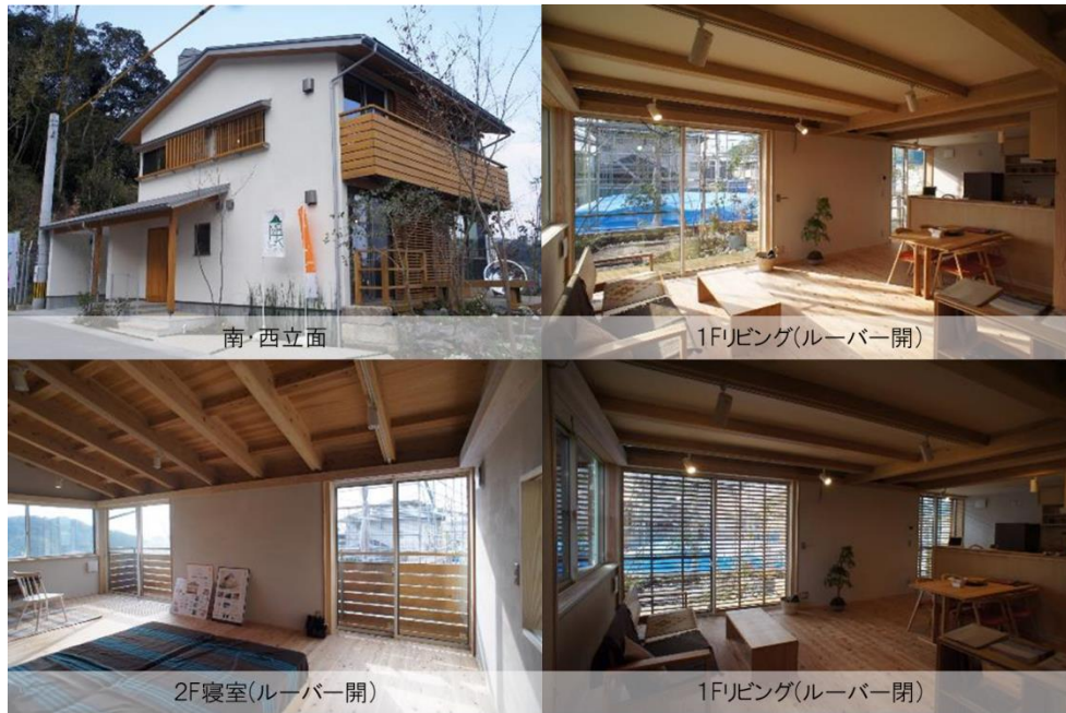
図 5-18 鹿児島市実証住宅の外観・内観
