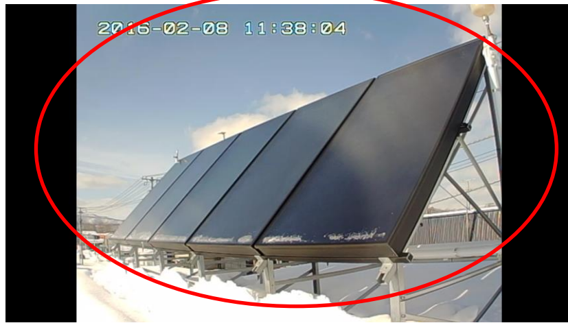
改築実証住宅（太陽熱温水パネル傾斜角 45^{\circ} ）ほぼ全面で積雪なし
