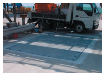
栈橋上面保護層としての利用
