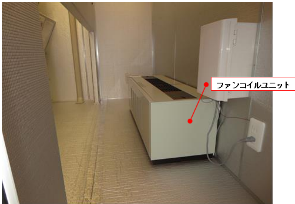
三菱電機冷熱応用システム(株) リビングマスターLV-WLFE-C (1台)
