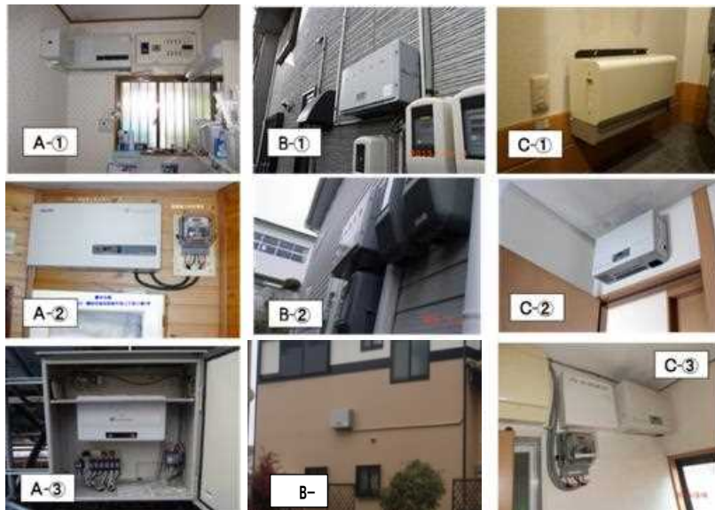
図Ⅲ-2-①-(1)-8 回収前の PCS の設置状況
