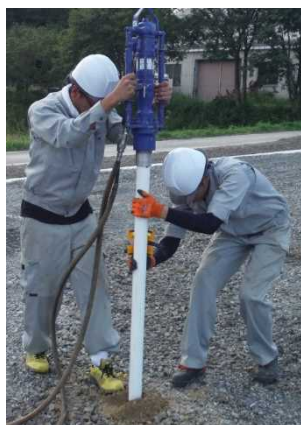
図Ⅲ-2-①-(6)-6 ハンド式の杭打ち機による杭 打設
