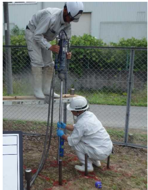
図Ⅲ-2-①-(6)-19 杭打設風景
