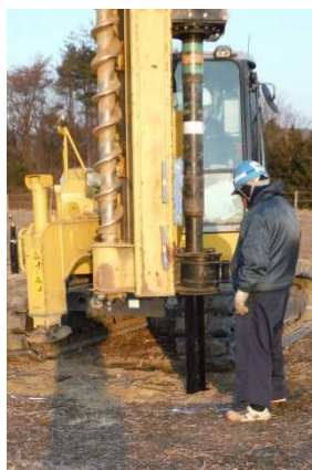
図Ⅲ-2-①-(6)-7 パイルドライバによる杭打設
