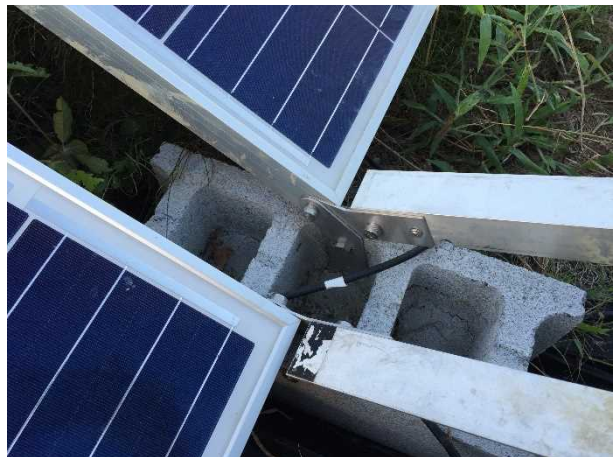
図Ⅲ-2-①-(4)-8 コンクリートブロックへの取り付け金具の固定
