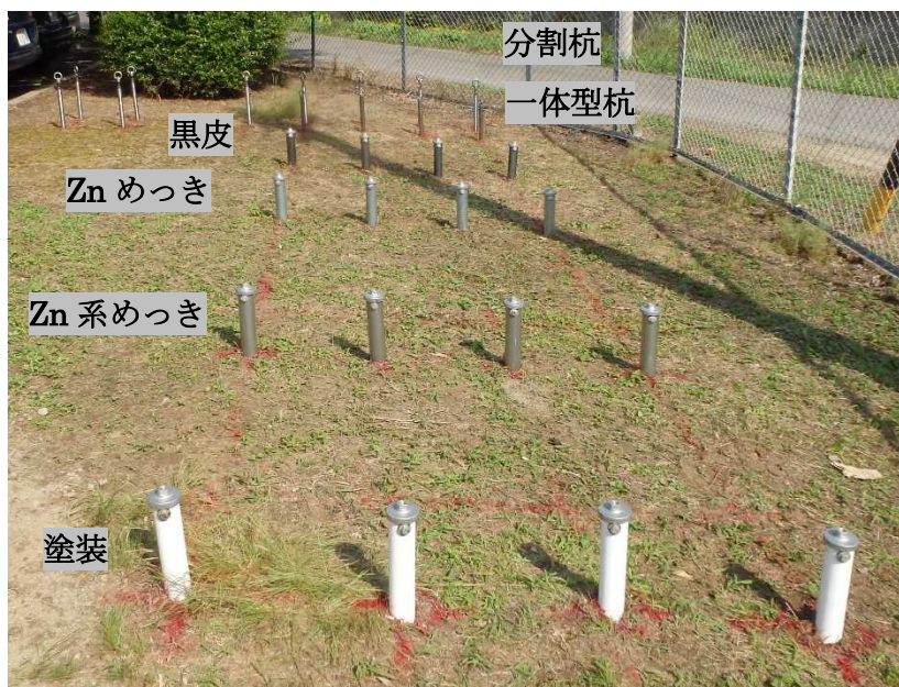
図Ⅲ-2-①-(6)-21 打設完了風景
