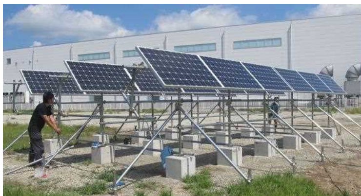
図Ⅲ-2-①-(3)-7 角度可変式架台の改良・低コスト化を実施
