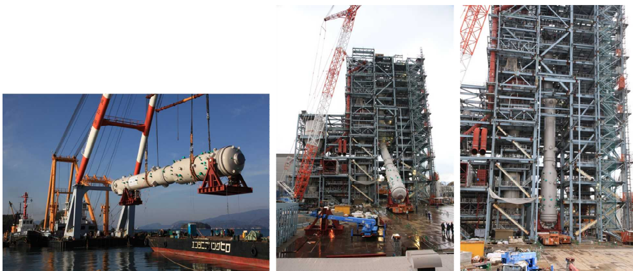
図 3-18 ガス化炉搬入・据付状況
