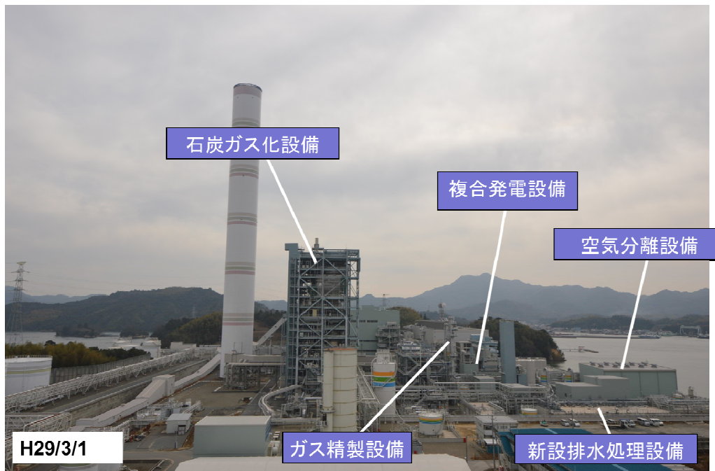
図 3-20 設備全体写真（西側より）
