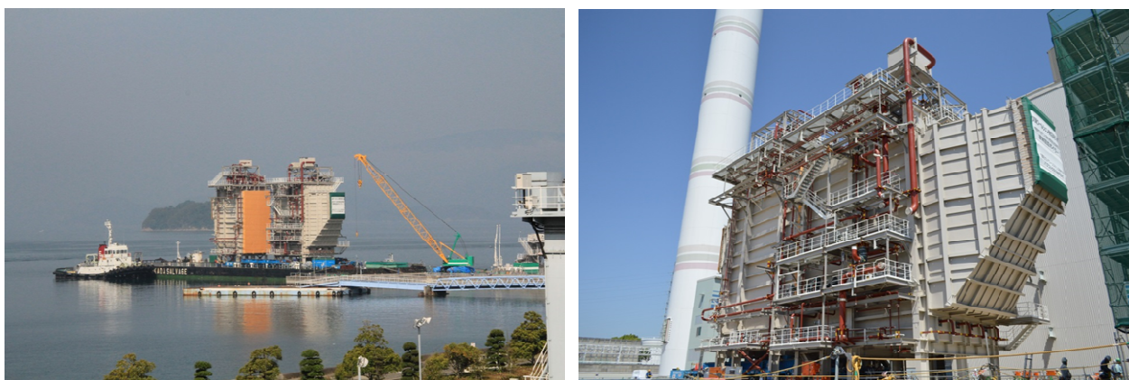
図 3-17 排熱回収ボイラ搬入・据付状況
