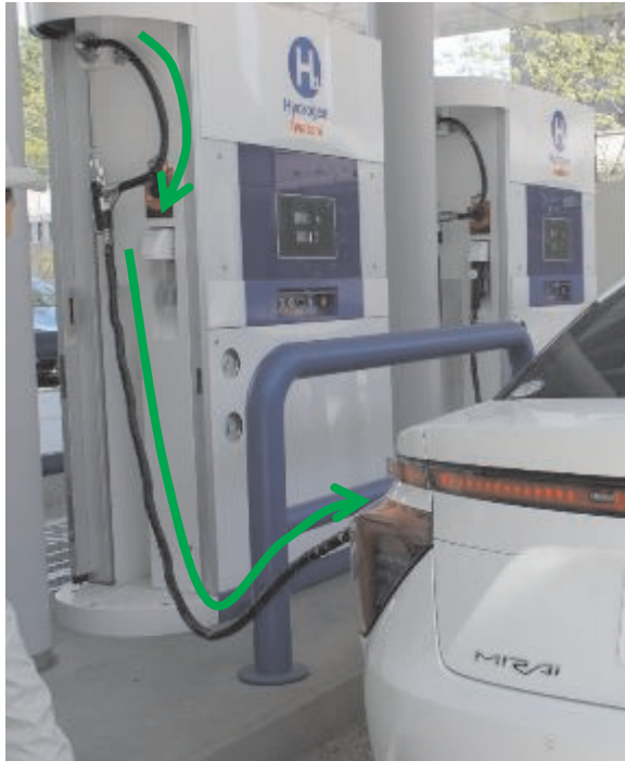
ステーションのホース使用状況
