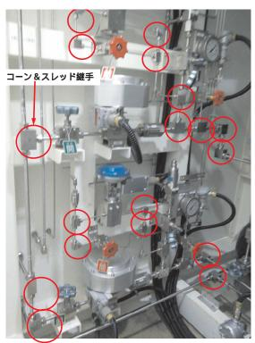
蓄圧器出側配管系の継手部位
