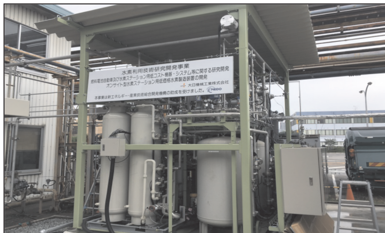
図 15 現地据付状態
