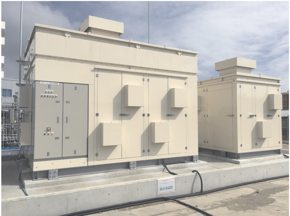
写真 1 「建設完了時の設備」
