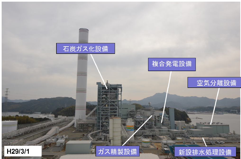
図 3-20 設備全体写真（西側より）
