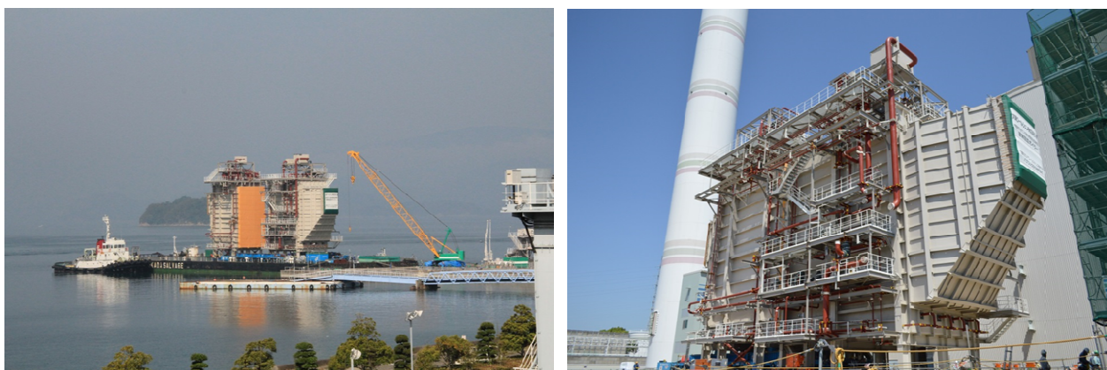
図 3-17 排熱回収ボイラ搬入・据付状況
