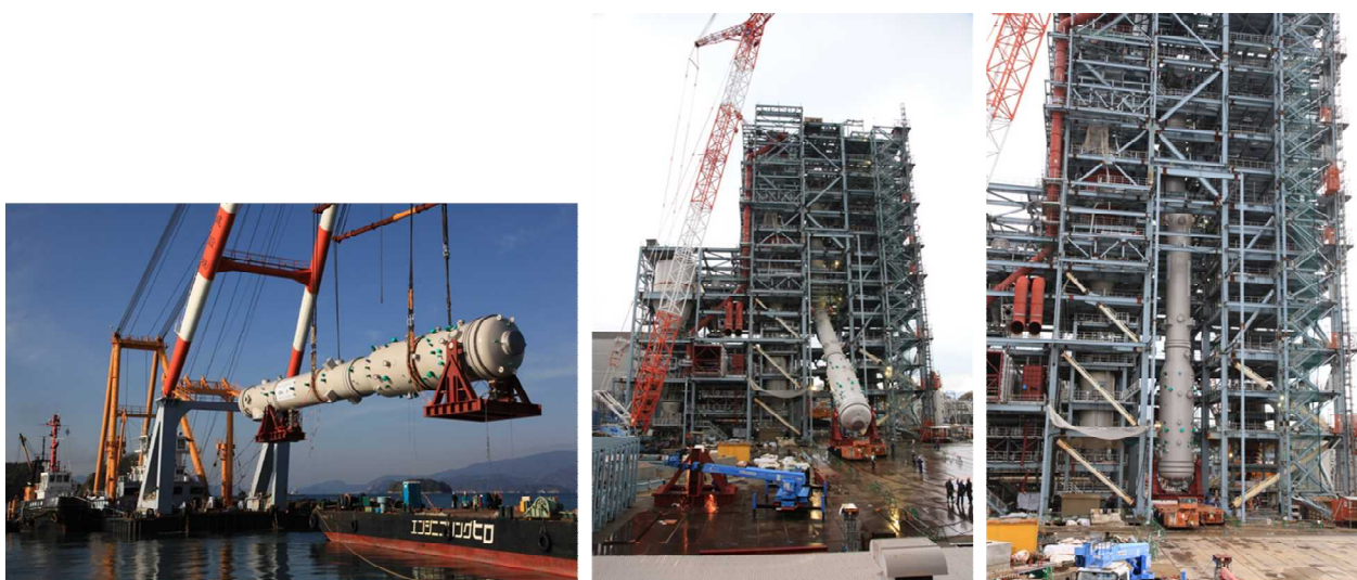
図 3-18 ガス化炉搬入・据付状況
