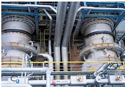
鹿島共同再資源化センター(茨城県)
