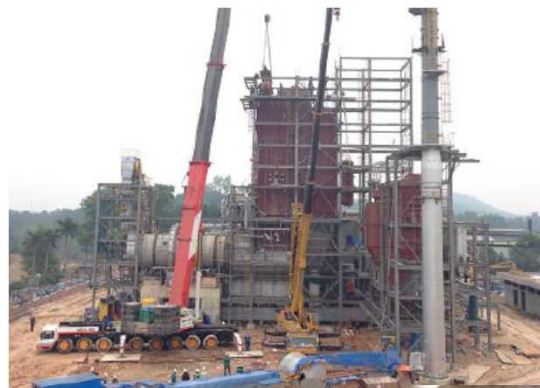
機器据付状況
