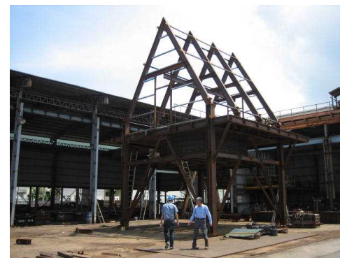
第三国調達機器の仮組み検査
