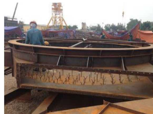
現地製作工場での検査
