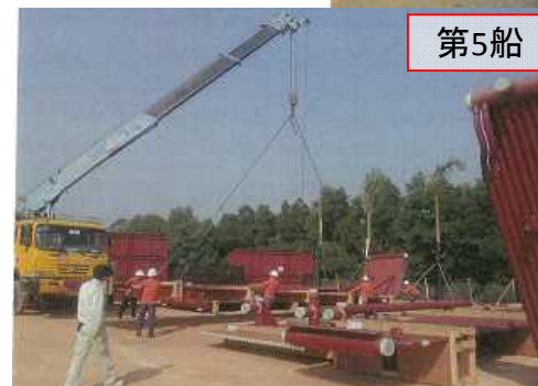
ボイラ 現地荷降ろし状況
