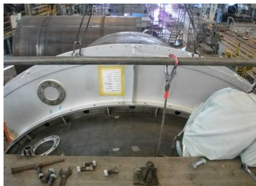
堺工場での仮組み立て
