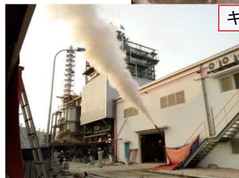
蒸気フラッシング
