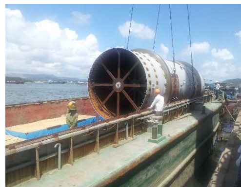
第1船 Cai Lan水切り状況
