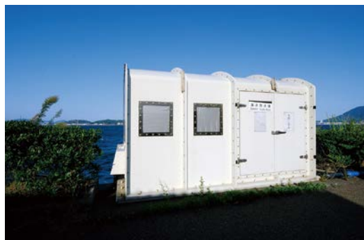
関門海峡に面した海水取水口
