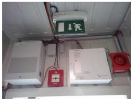
消防署への通信装置
