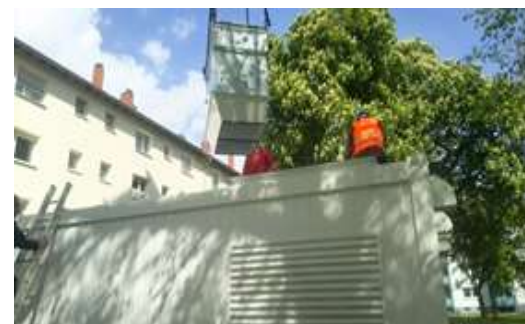
サイレンサの設置 (インバータのスイッチングの際の高周波音、 ファンの動作音の低減)
