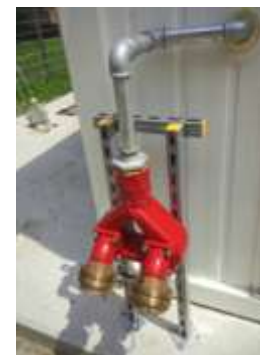
コンテナ外からの注水口
