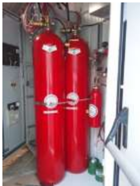
自動消火設備用ガスボンベ
