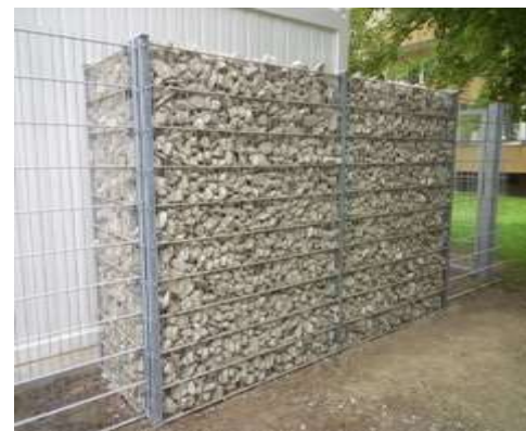
室外機の室内設置および遮音壁設置
