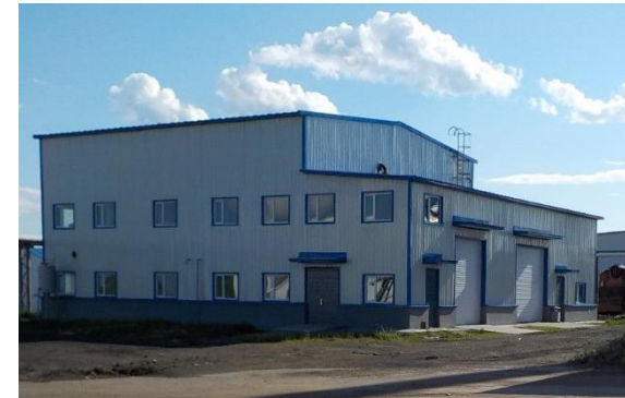
(プラント外観)
