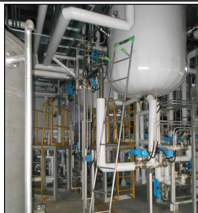
< 酵素生産槽下部外観 >
