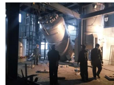
機器据付工事状況
