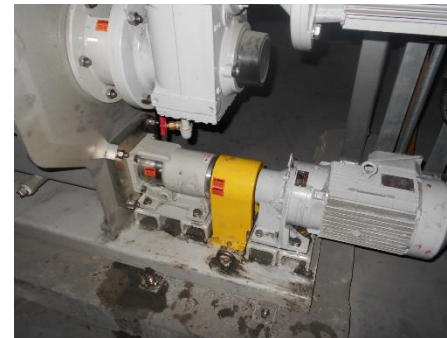
原料移送ポンプの単体試運転
