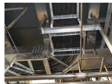
電気計装・工事状況
