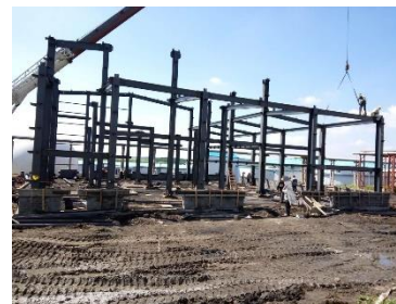
プラント建屋建設 工事状況
