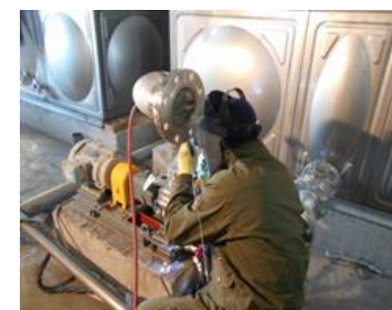
配管工事状況
