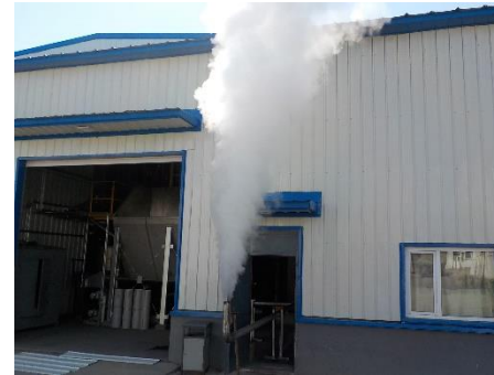
配管蒸気フラッシング
